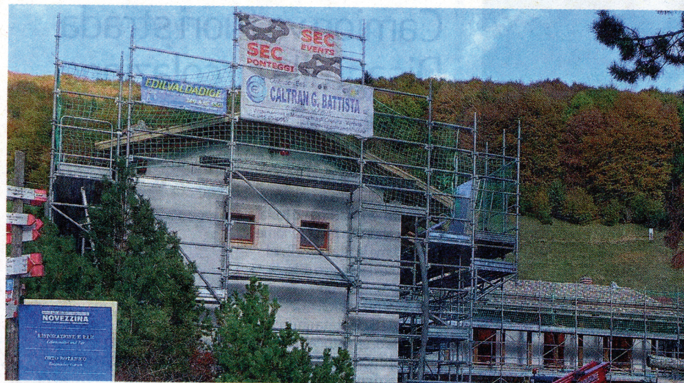
Il cantiere aperto al rifugio Novezzina per rifare tetto e balconata
